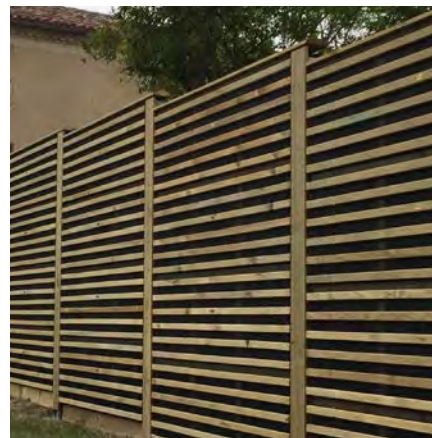
Poteaux en acier recouverts par une planche en bois
