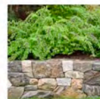
Mur en pierres et végétation
